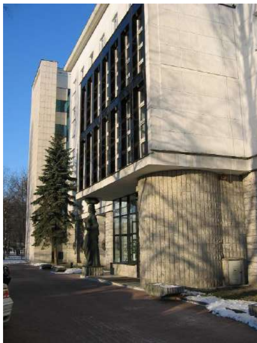
Siedziba UPRP w Warszawie al. Niepodległości 188/192
